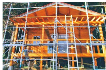
改修中のダッドレーキャビン
